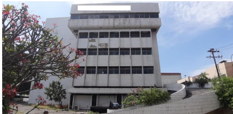
Gambar 1: Gedung eksisting yang ditinjau
