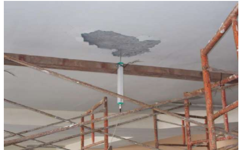
Penempatan LVDT di tengah bentang plat
