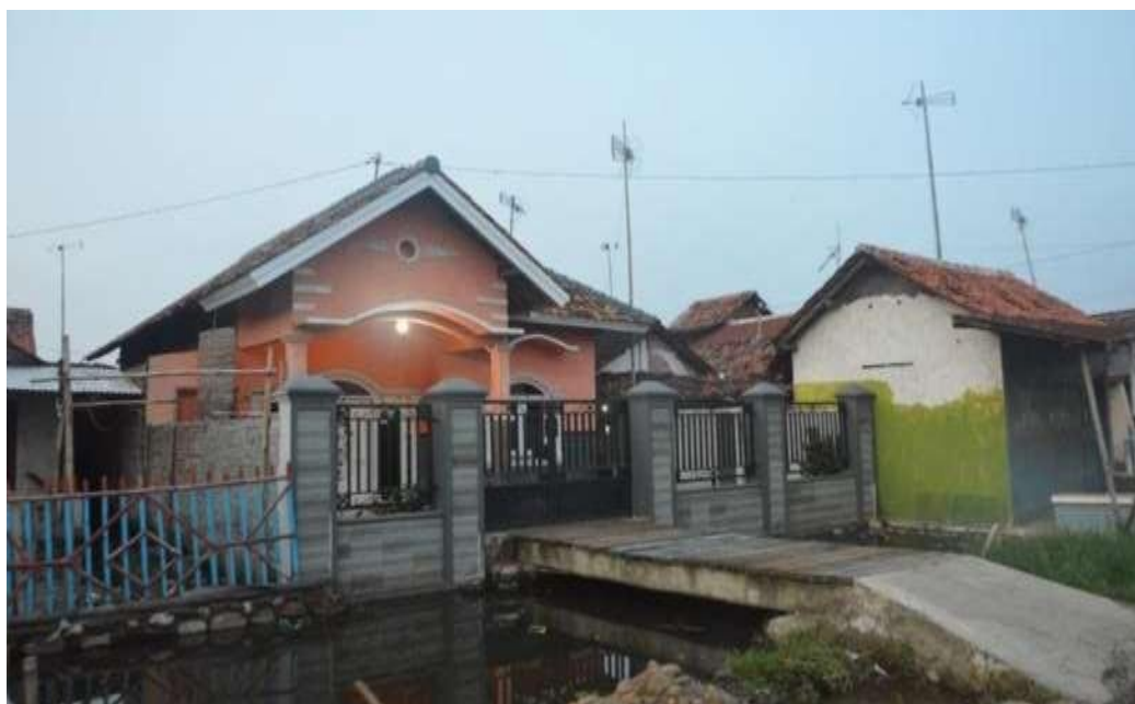
Gambar 2.2. Peninggian Elevasi Rumah Warga (Sumber : Marfai, 2014)
