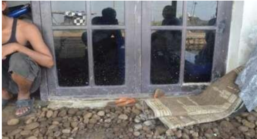
Gambar 2.1. Peninggian lantai rumah sampai setinggi jendela sebagai bentuk adaptasi banjir rob di Desa Grugu Cilacap ((Wahyudi et al., 2015))
