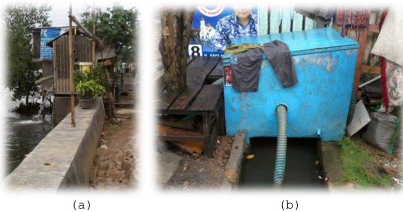
(a) Pompa aktif mengalirkan air banjir dan rob ke sungai di RW 09 (b) Pompa penyedot air dari pemukiman warga
