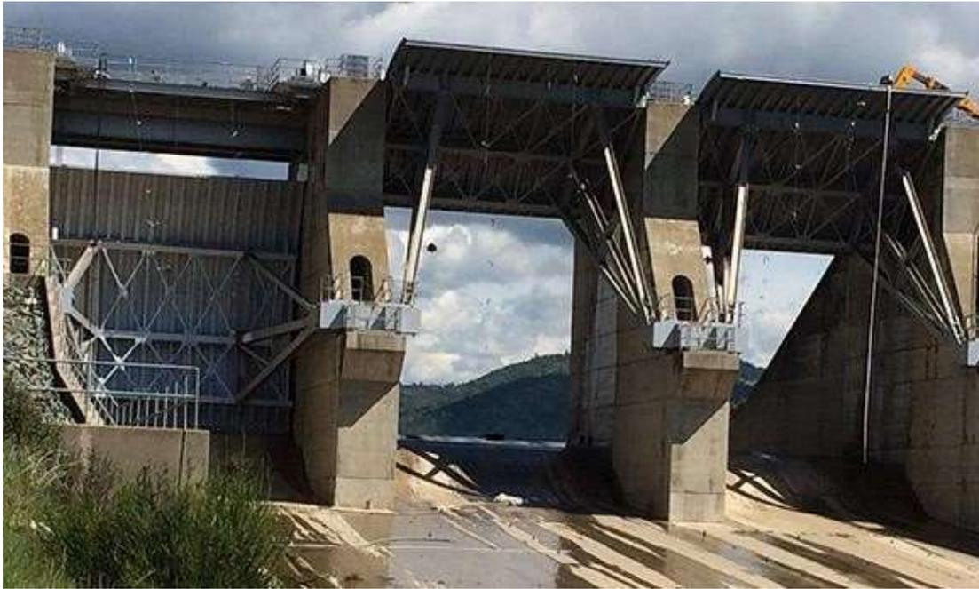
Gambar 2.8. Bendung New Hogan dengan Pintu Radial (Sumber : Lemke Industrial, 2001)
