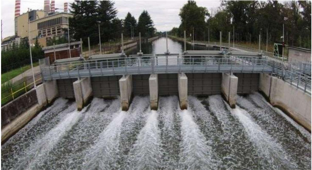
Gambar 2.9. Pintu Bendung tipe Geser (Sumber : PoolMecanical, 2013)
