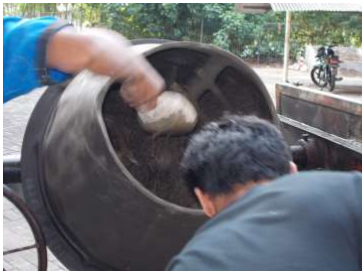
Penuangan agregat
