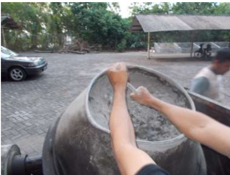
Proses penuangan serat / fiber
