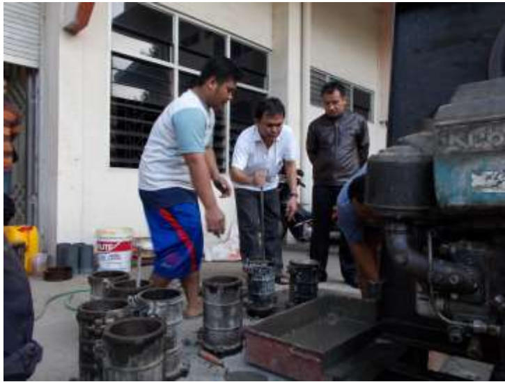
Proses pengadukan beton
