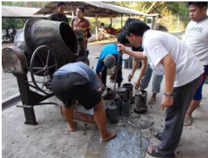
Penuangan adukan beton ke cetakan
