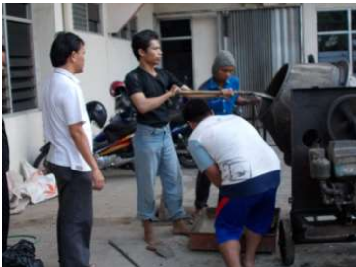
Proses pengadukan beton
