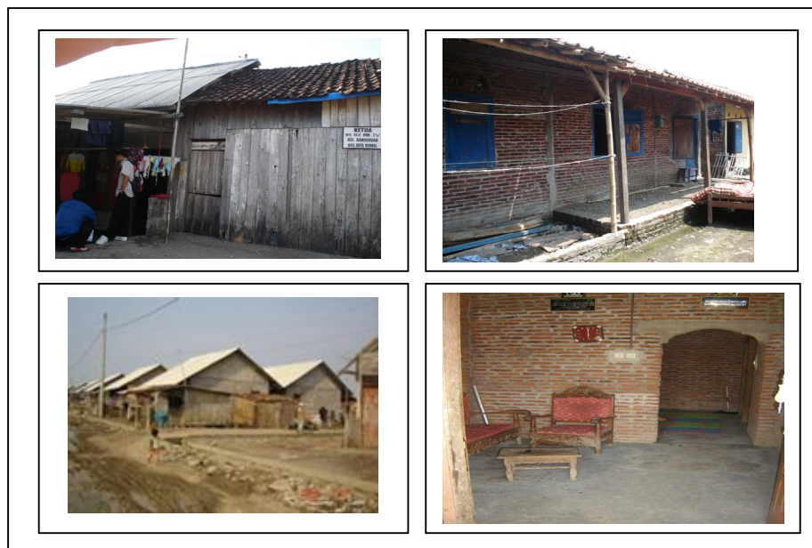
Gambar 5.2. Visualisasi Beberapa Rumah Permanen dan Semi Permanen dengan Dinding terbuat dari Tembok/Papan dan lantai Plesteran/Tanah
