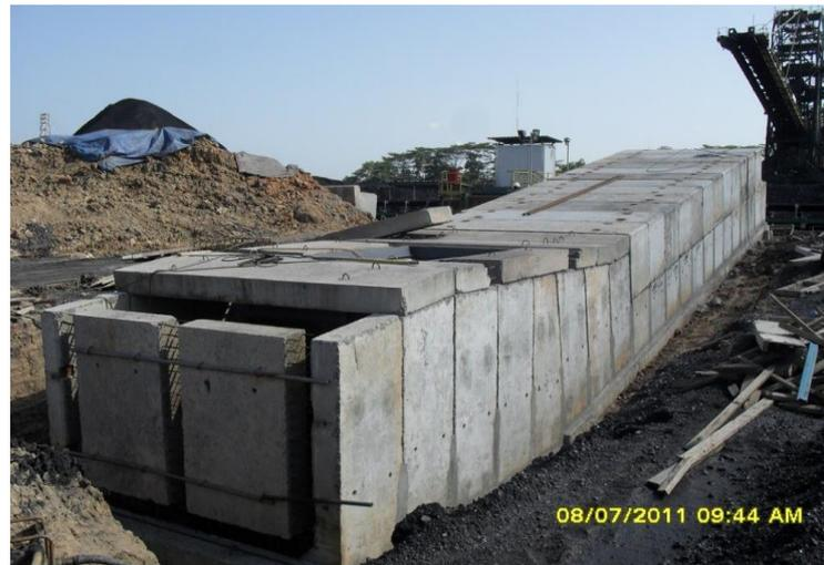
Gambar 11. Struktur Tunnel pracetak terpasang
