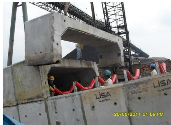
Gambar 10. Pemasangan segmen pracetak
