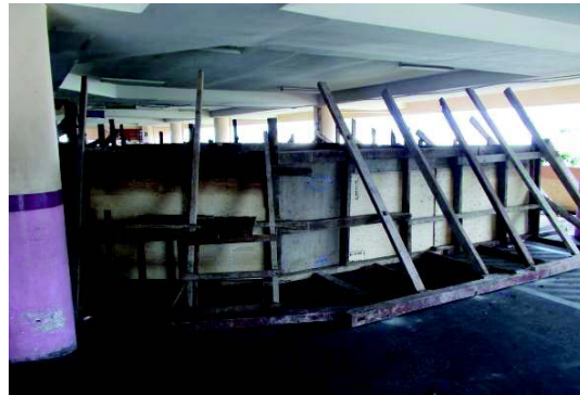
Gambar 10. Pemasangan bekisting untuk Loading Test
