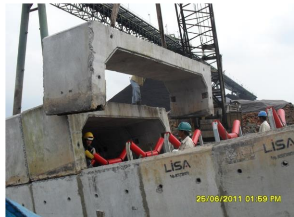
Gambar 10. Pemasangan segmen pracetak
