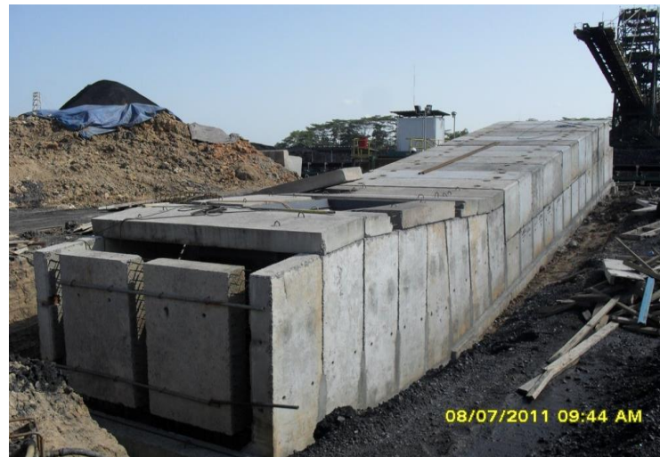
Gambar 11. Struktur Tunnel pracetak terpasang
