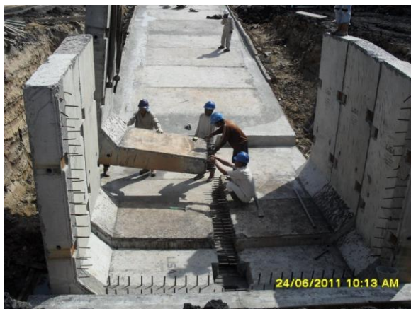
Gambar 10. Pemasangan segmen pracetak
