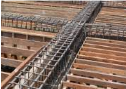
(a) Penulangan balok dan persiapan cetakan plat
