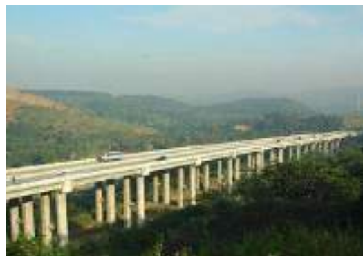
(b) Pilar jembatan tol Cipularang
