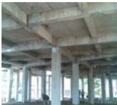
a) Struktur kolom, balok, plat
