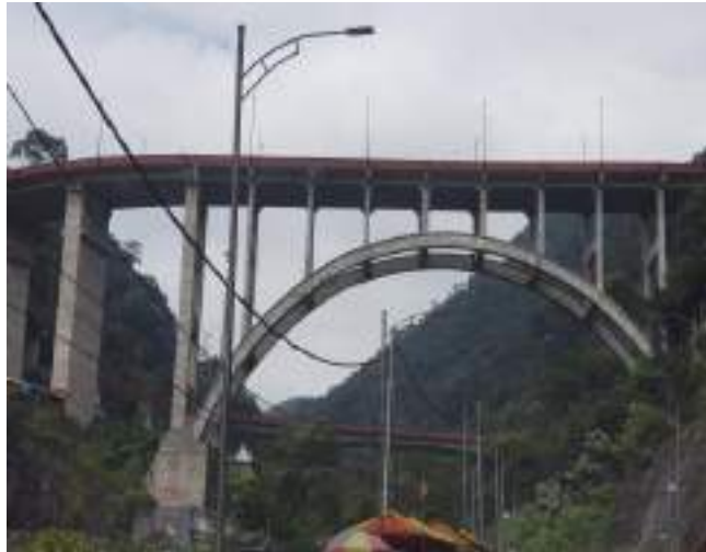
Gambar 1.6. Jembatan Pelengkung, Payakumbuh, Sumatra Barat
