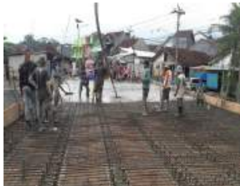
(c) Pengecoran balok dan plat bersamaan
