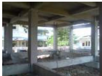
(d) Kolom yang telah selesai di cor
