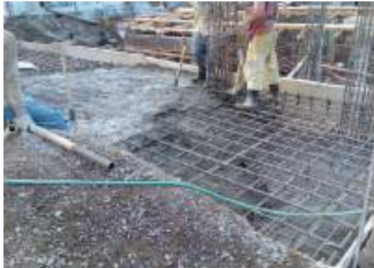
Gambar 2.27. Kondisi saat pengerjaan beton segar di lapangan
