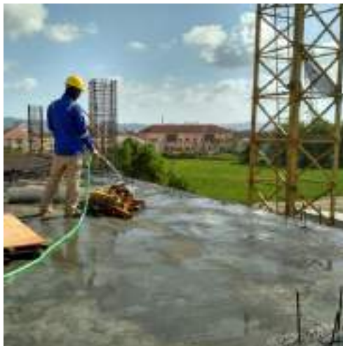
Gambar 2.30. Perawatan beton secara konvensional
