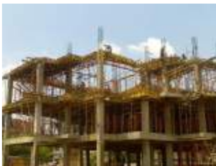
(c) Pelaksanaan kolom pada gedung
