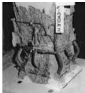
Gambar 12.5. Buckling pada tulangan longitudinal (Bayrak & Sheikh, 2001)
