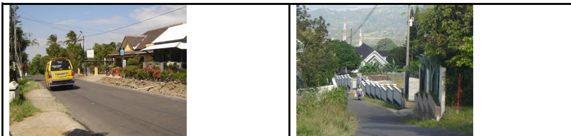
Gambar 3.5 Kondisi jalan-jalan di Desa Jetis dengan lebar jalan kurang lebih 5-6 meter. Jaringan jalan ini menghubungkan Ambarawa-Bandungan, sehingga menjadi salah satu akses utama bus-bus pariwisata menuju Bandungan
